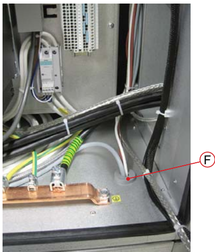
Figuur 3.19 F: Doorvoer voor HTCO/PT1000
