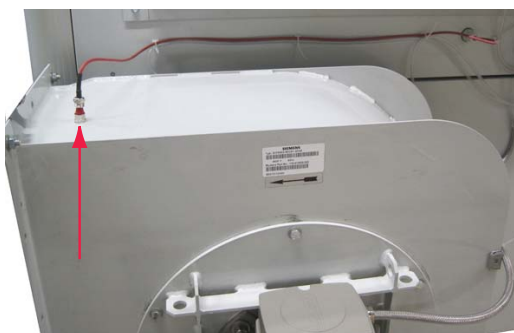
Figur 3.21 PT1000-anlutning på regenereringsfläkt
