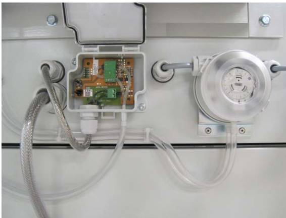
Abb 3.22 Anschluss für Differenzdruck-Messumformer (Regenerationsventilator)
