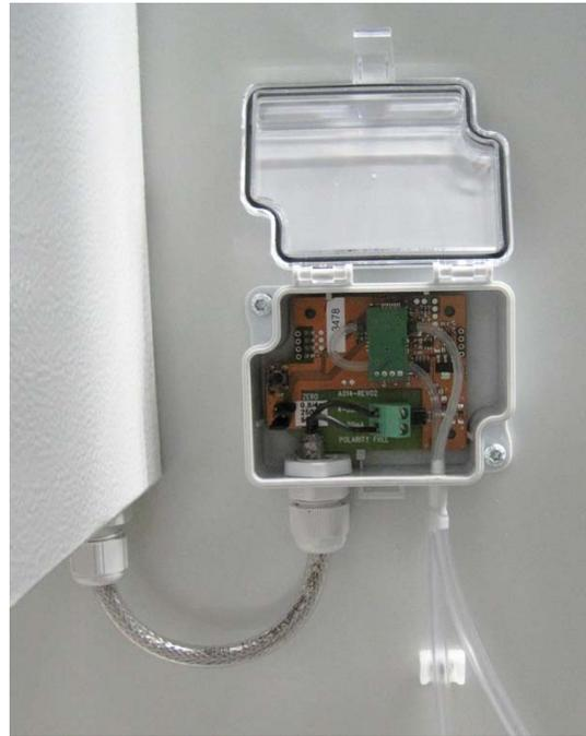
Figura 3.23 Conexión del DPT (ventilador de proceso)
