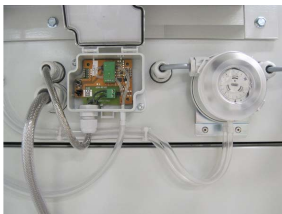
Figuur 3.22 Aansluiting DPT (regeneratieventilator)
