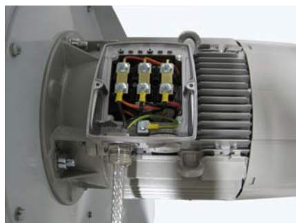
Figuur 3.15 Ventilatormotorbedrading
